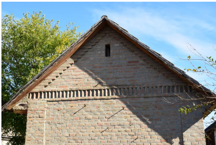
Melléképület homlokzata látszó téglafelülettel
