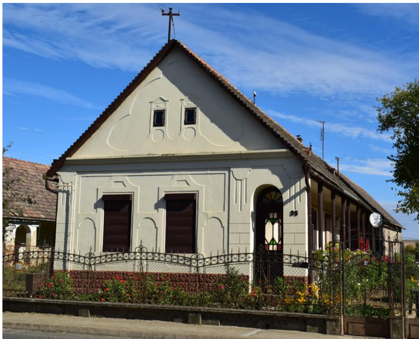
Hagyományőrzően felújított lakóház a Nagy utcában
